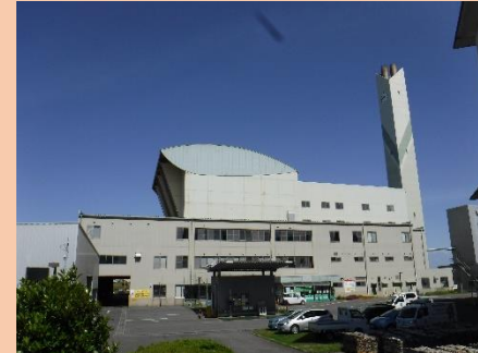
【No.60 災害廃棄物の運搬、処理に係る対策】 （達成KPI：中津市クリーンプラザ基幹的設備改良工事（事業完了））
